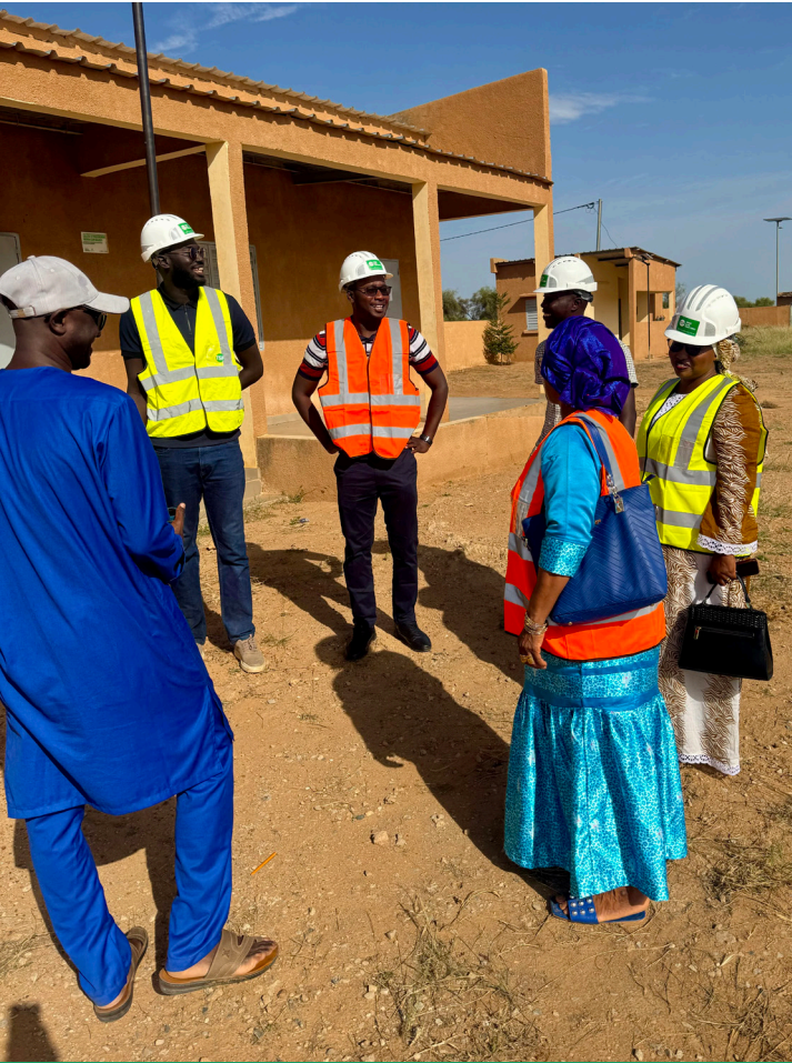
Bernard Coly (au centre), lors d'une visite de chantier à Loumbal Baladji, dans le cadre du programme Jeunesse YEESO.
